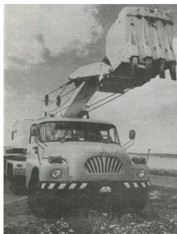
Automobilní podvozek lanového rýpadla
